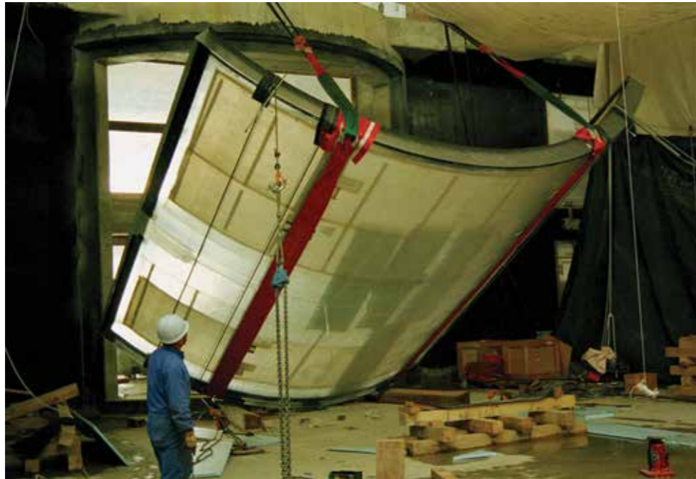
Figura 4 – Instalação das Janelas.
