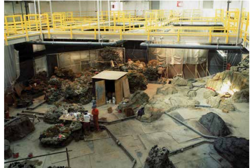
Figura 6 – Finalização das Instalações.
