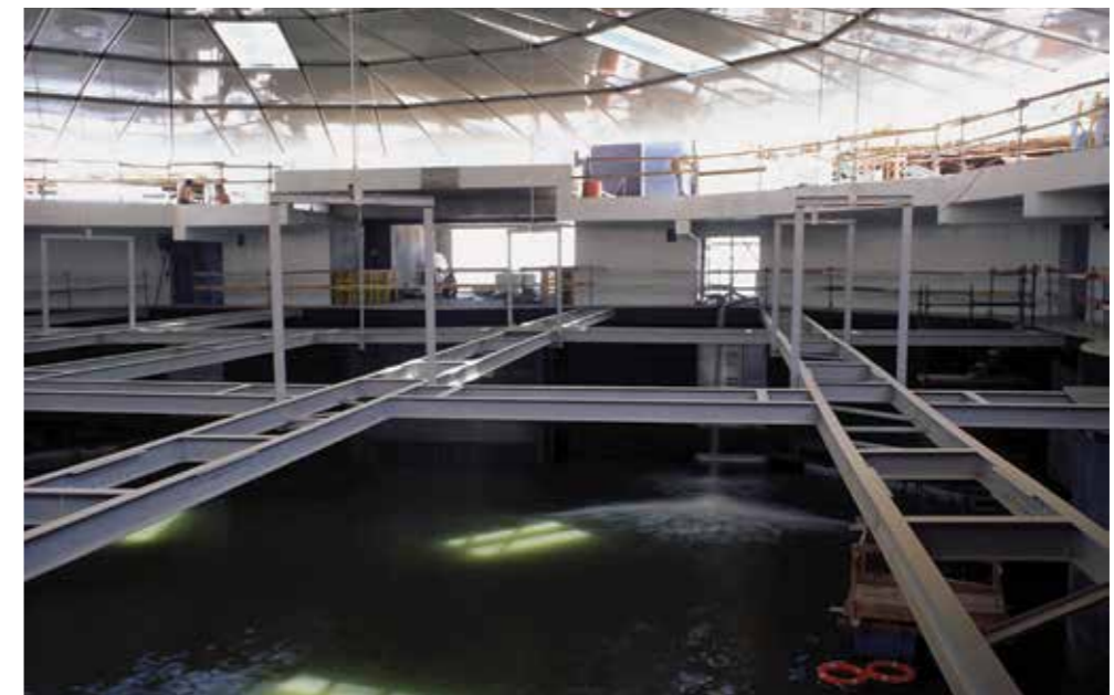
Figura 3 – Teste Hidráulico das Janelas.
