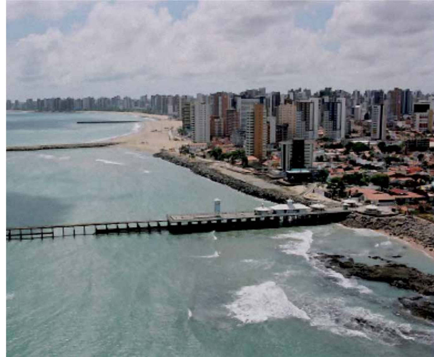
Figura 20 – Processo Erosivo na Cidade de Fortaleza.
