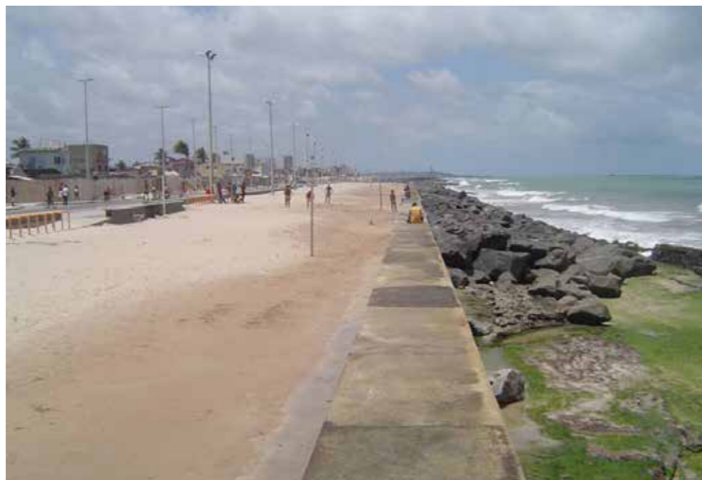
Figura 31 – Comunidade Brasília Teimosa (Recife-PE) urbanizada.
