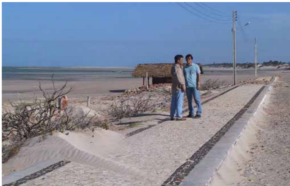
Figura 4 - Erosão em Morgado (Acará-CE).
