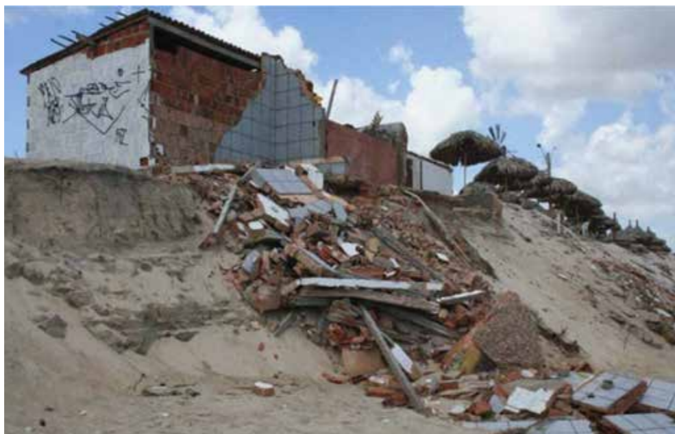
Figura 3 - Erosão em Icaraí (Caucaia-CE).
