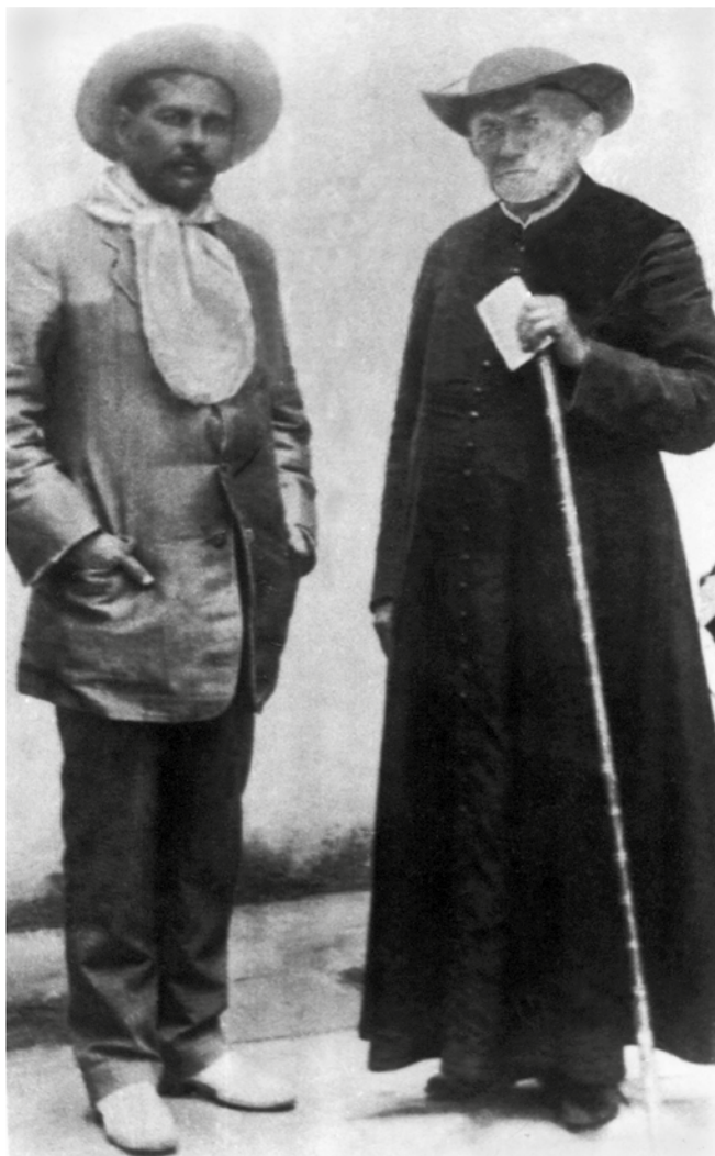
Ilustração 5 – Chegada de Floro Bartholomeu da Costa a Juazeiro do Norte, recebido pelo Pe. Cícero Romão Baptista, 1908
