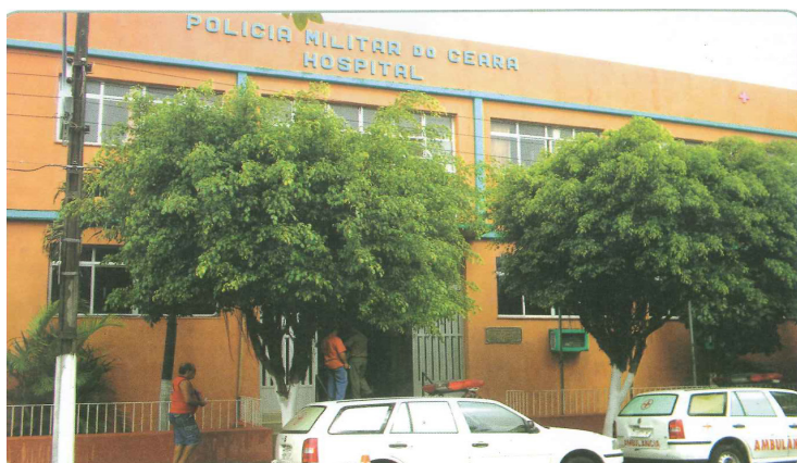
Figura 14 – Fachada do Hospital da PM em 2006
