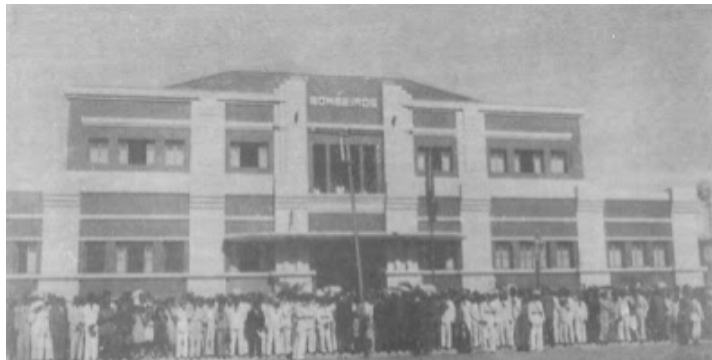
Figura 9 - Quartel do Corpo de Bombeiros – 1934 (inauguração) e 2017
