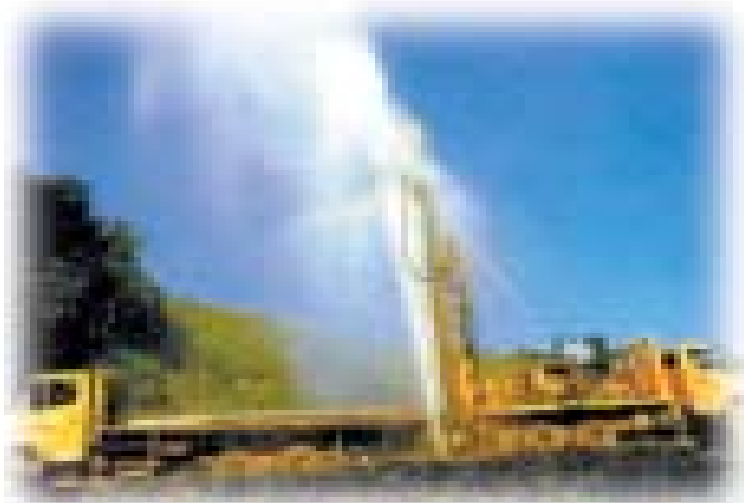
Poço Pioneiro de Violeto no Piauí - Vale da Gurguéia. A vazão dos poços da região supera na maioria das vezes 400.000 l./h suficientemente na irrigação de centenas de hectares de terras.
