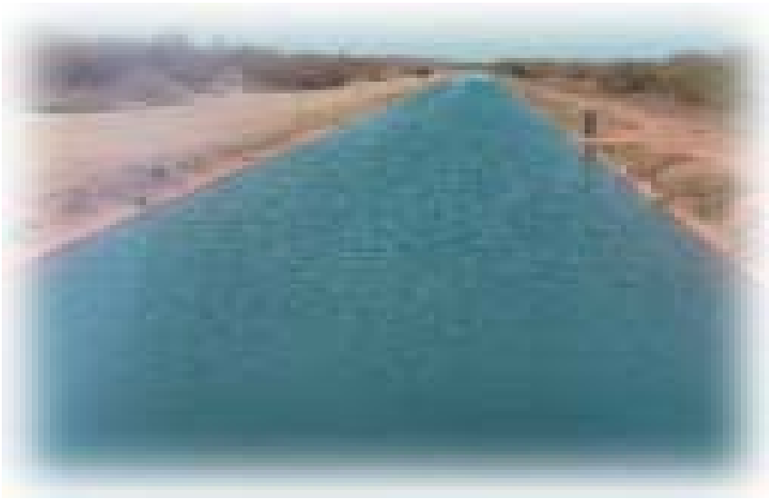
Canal de irrigação do Tabuleiro de Russas Baixo Jaguaribe em pleno funcionamento, atendendo à demanda do projeto regional.
