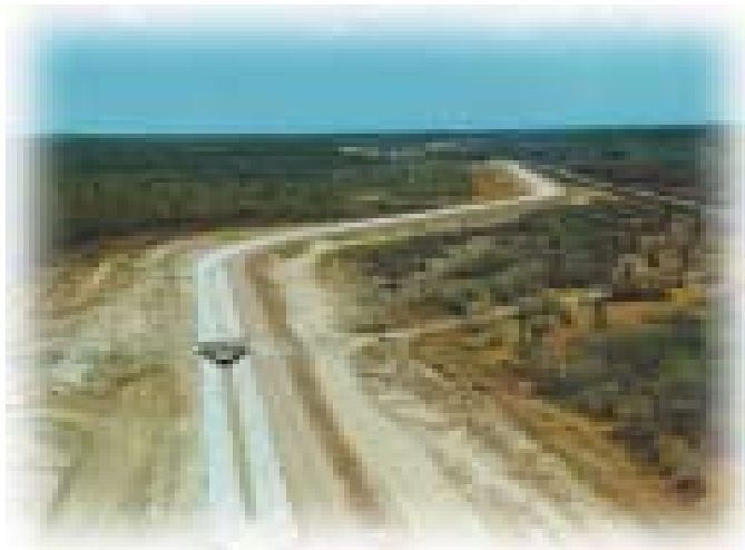
Canal Caucaia - Porto do Pecém, obra hídrica altamente necessária para o desenvolvimento do complexo industrial. Pode também ser aproveitado na irrigação e no abastecimento da população da região.
