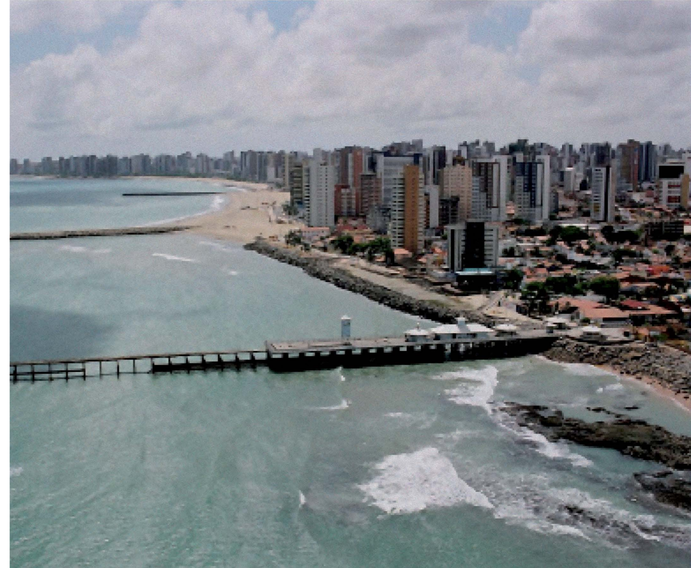
Figura 20 – Processo Erosivo na Cidade de Fortaleza.
