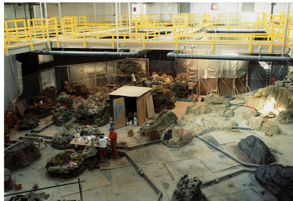
Figura 6 – Finalização das Instalações.
