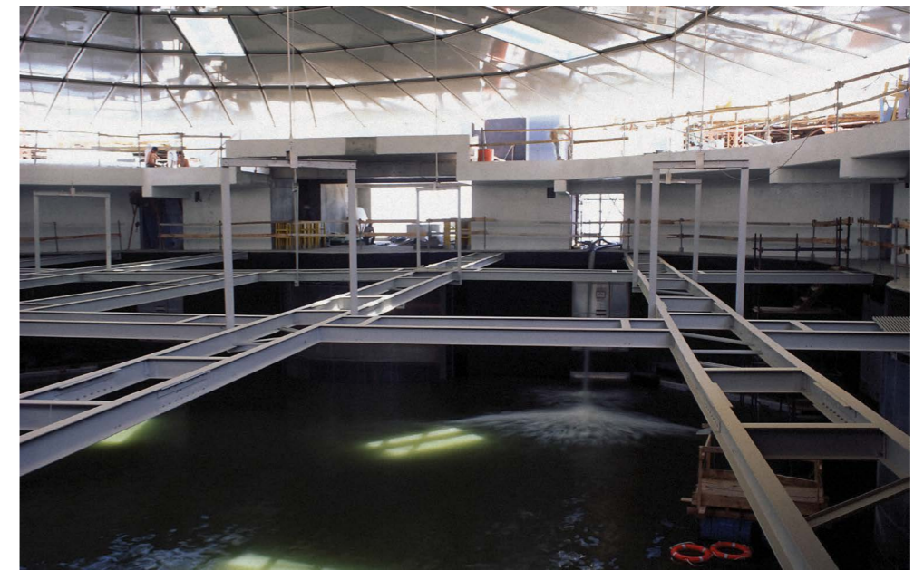
Figura 3 – Teste Hidráulico das Janelas.
