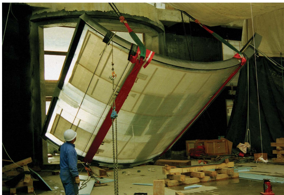
Figura 4 – Instalação das Janelas.
