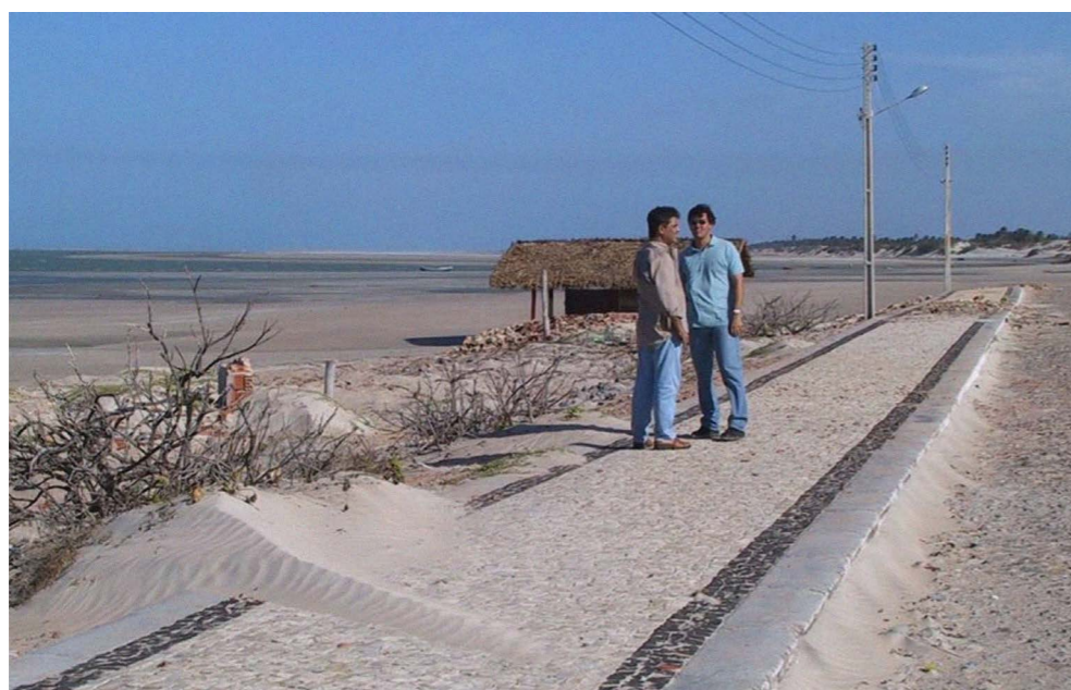
Figura 4 - Erosão em Morgado (Acarai-CE).
