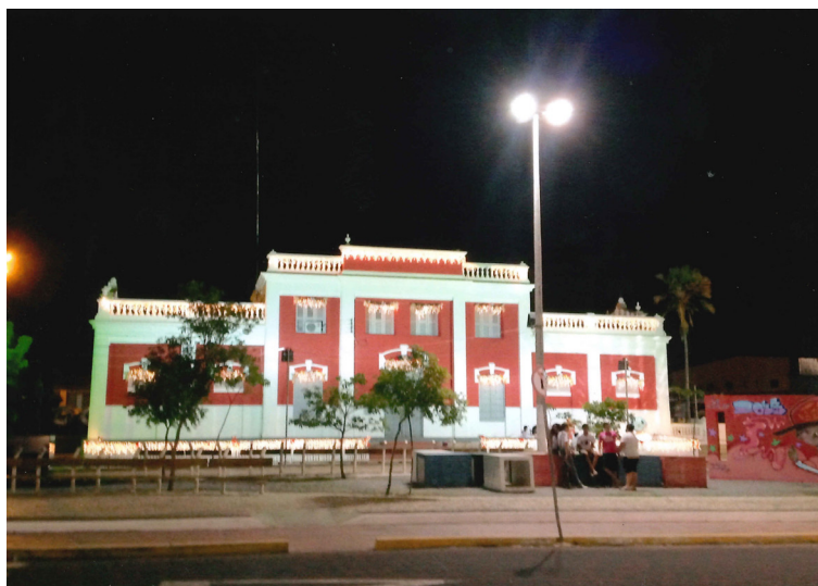
Estação Ferroviária de Crateús
