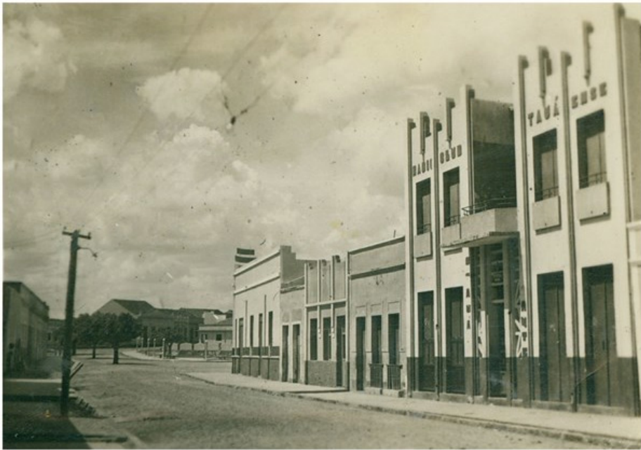
Foto da sede da Radio Clube de Tauá situada no prédio hoje abrigando a Câmara Municipal
