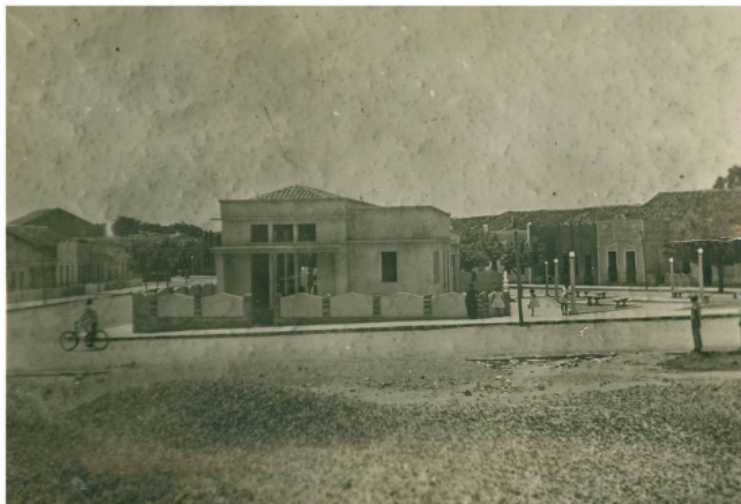
Prédio do antigo Correios e Telégrafos de Tauá
