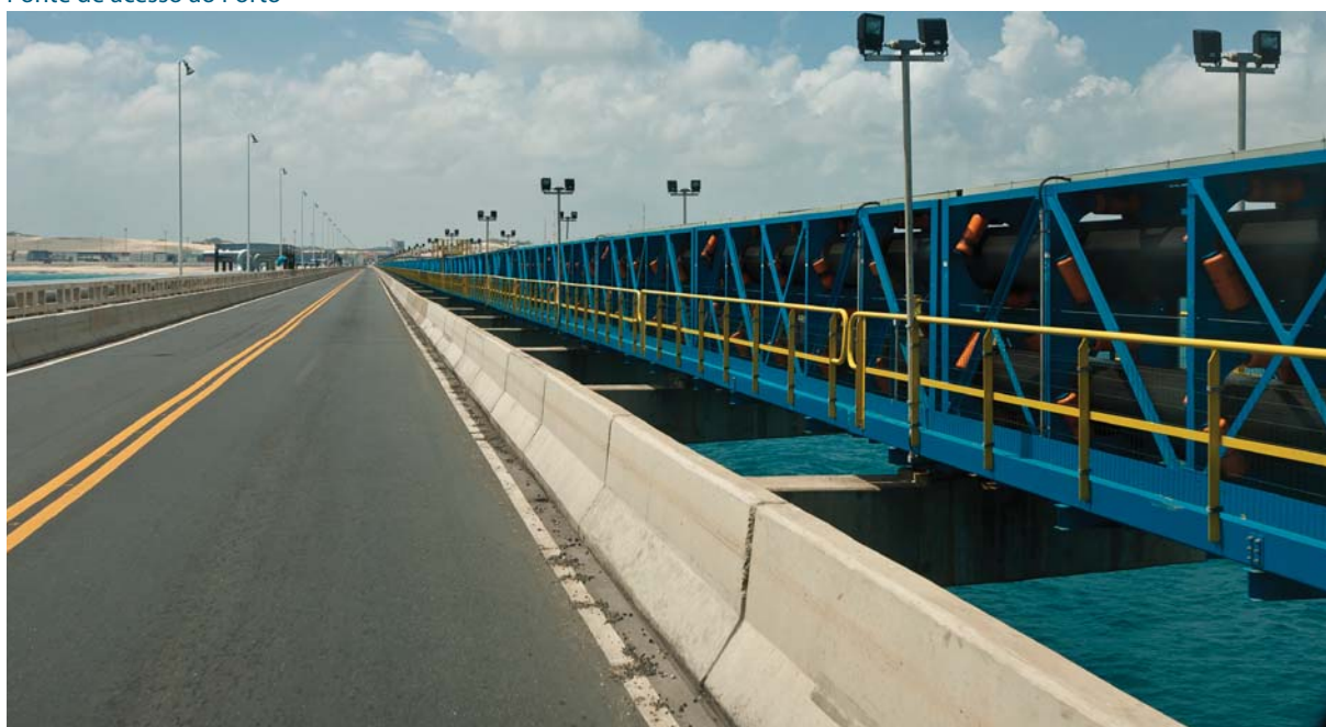
Ponte de acesso ao Porto
